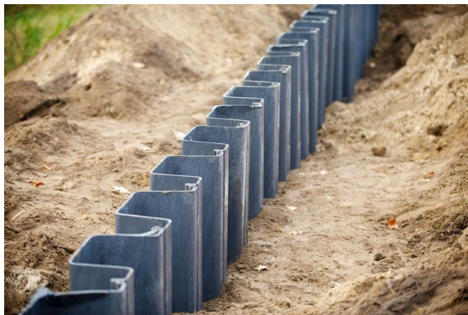
Рис. 3. Шпунтовая стенка
