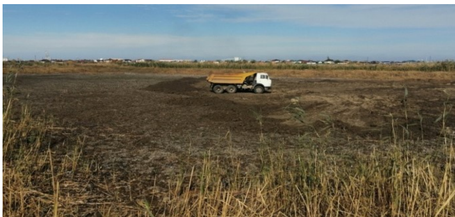
Рис. 4. Иловые площадки Южных очистных сооружений
