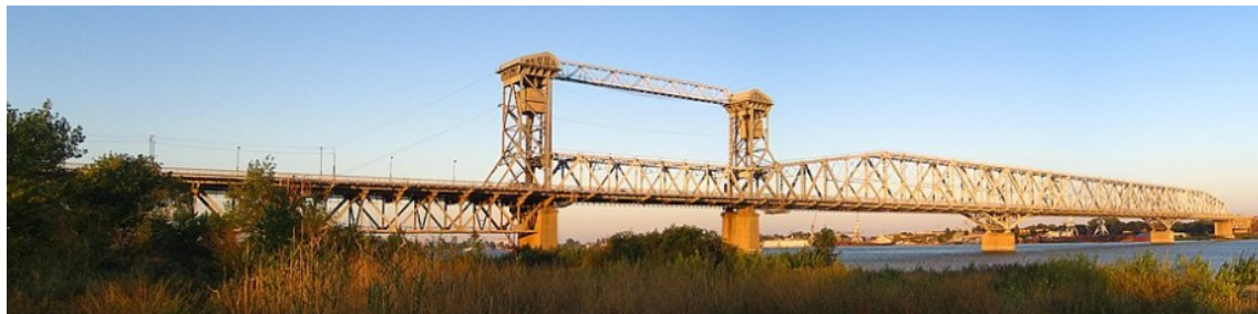
Рис. 2. Металлический мост через реку Волга в г. Астрахани
