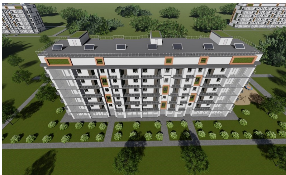
Рис. 2. Размещение фототермических коллекторов на крыше здания
