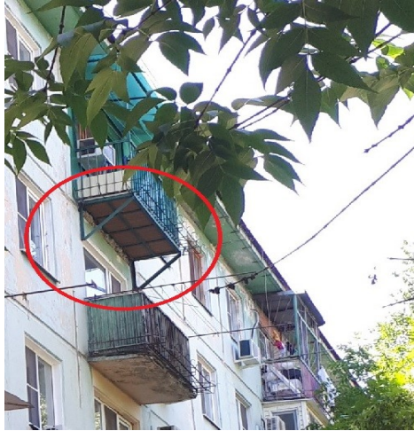
Рис. 1. Вариант усиления балконной плиты
