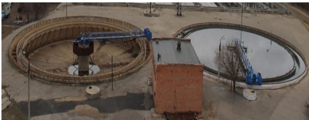
Рис. 3. Первичные отстойники Южных очистных сооружений
