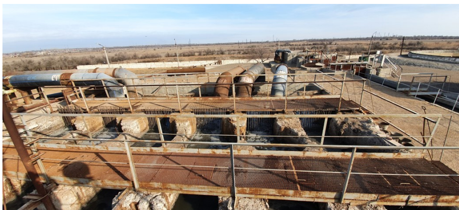
Рис. 5. Приемная камера Северных очистных сооружений канализации
