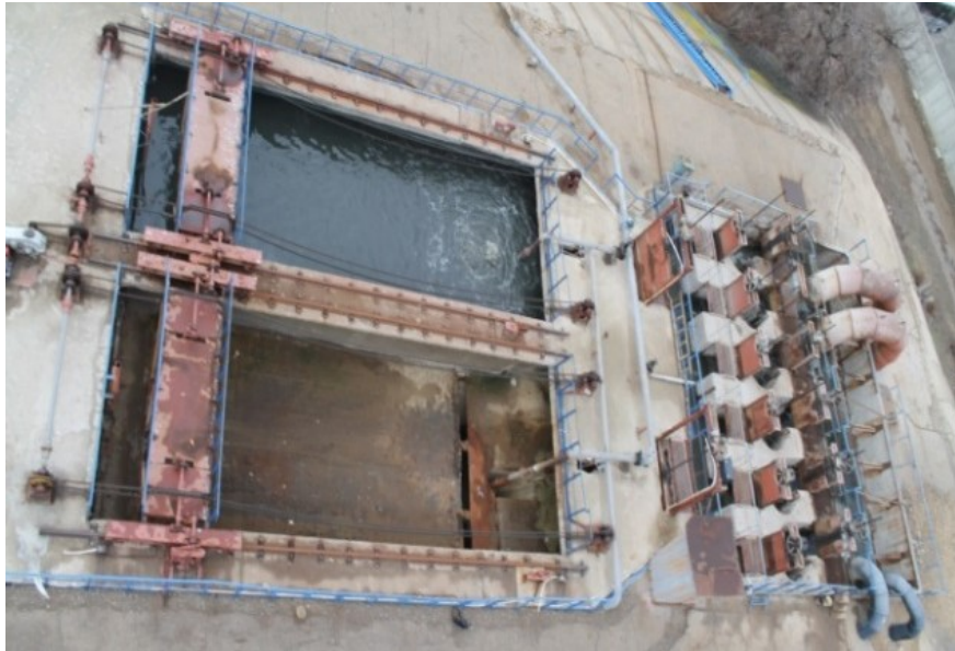
Рис. 2. Песколовки Южных очистных сооружений
